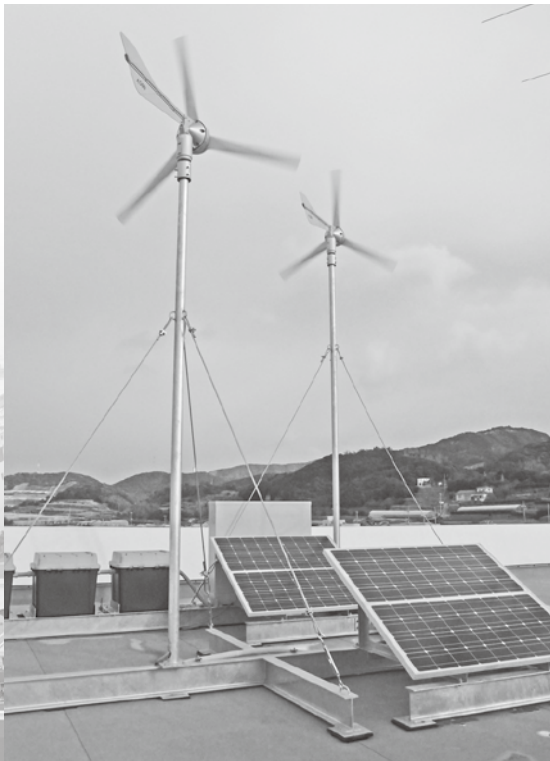
ハイブリッド配電システム
