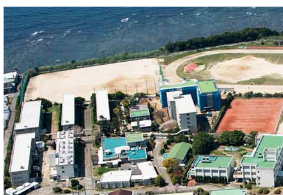
学生寮全景（平成26年4月）
