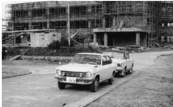
土木棟建設工事
