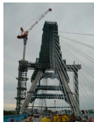
愛知万博への取り付け道路の建設
