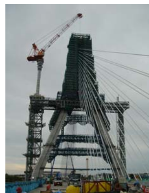
愛知万博への取り付け道路の建設
