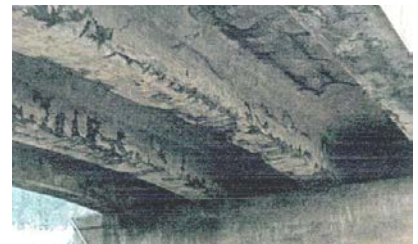
塩害劣化の状況
