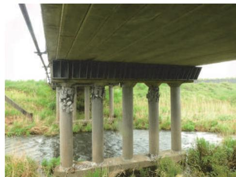
写真6 コンクリート橋脚の損傷現場
