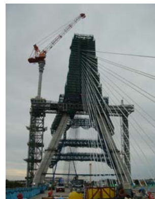
愛知万博への取り付け道路の建設
