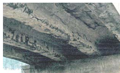
塩害劣化の状況
