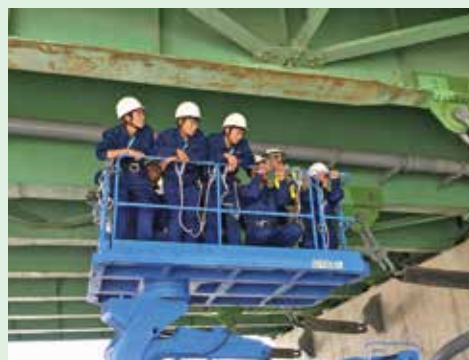
現場見学(道路橋の点検)
