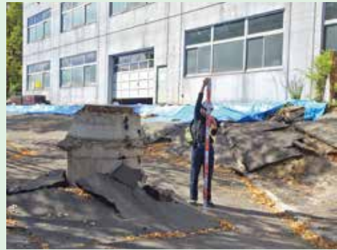
地震災害の現地調査の様子： 平成30年北海道地震
