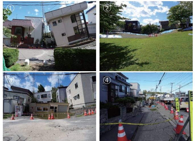
図 2 宅地、道路の V 字型地盤沈下
