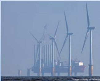
サネット洋上風力発電所(英国)の建設風景
