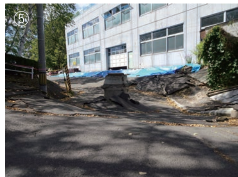
図 3 地盤沈下箇所突出したマンホール
