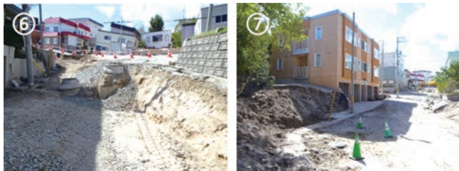
図4 地盤沈下区域と流出土砂堆積区域の境界付近における地形の変状
