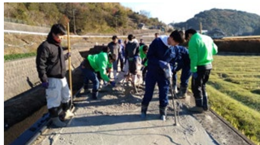
農道舗装工事のボランティア活動 (御坊市明神川地区)
