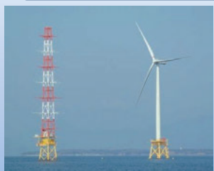
北九州市沖実証施設 出典: NEDO
