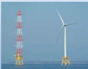
北九州市沖実証施設 出典: NEDO
