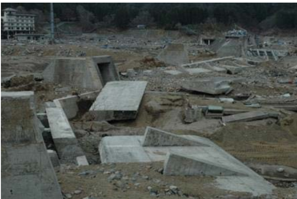
岩手県宮古市田老地区の「万里の長城」と呼ばれた防潮堤の崩壊の様子
