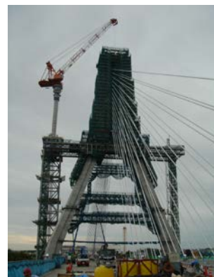
愛知万博への取り付け道路の建設
