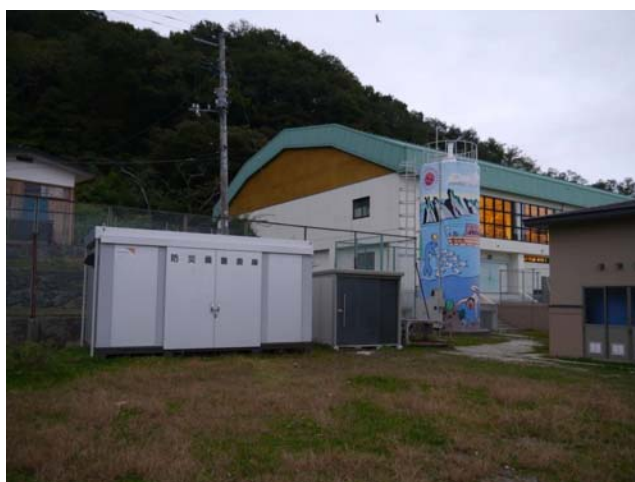
写真12 宮古小学校の防災備蓄倉庫と非常用水タンク
