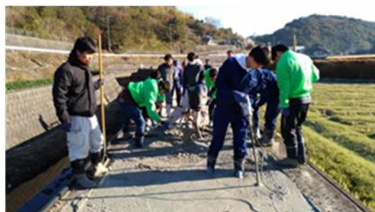
農道舗装工事のボランティア活動 (御坊市明神川地区)
