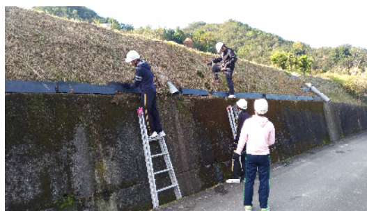
農場法面足場設置工事のボランティア活動 (御坊市明神川地区)
